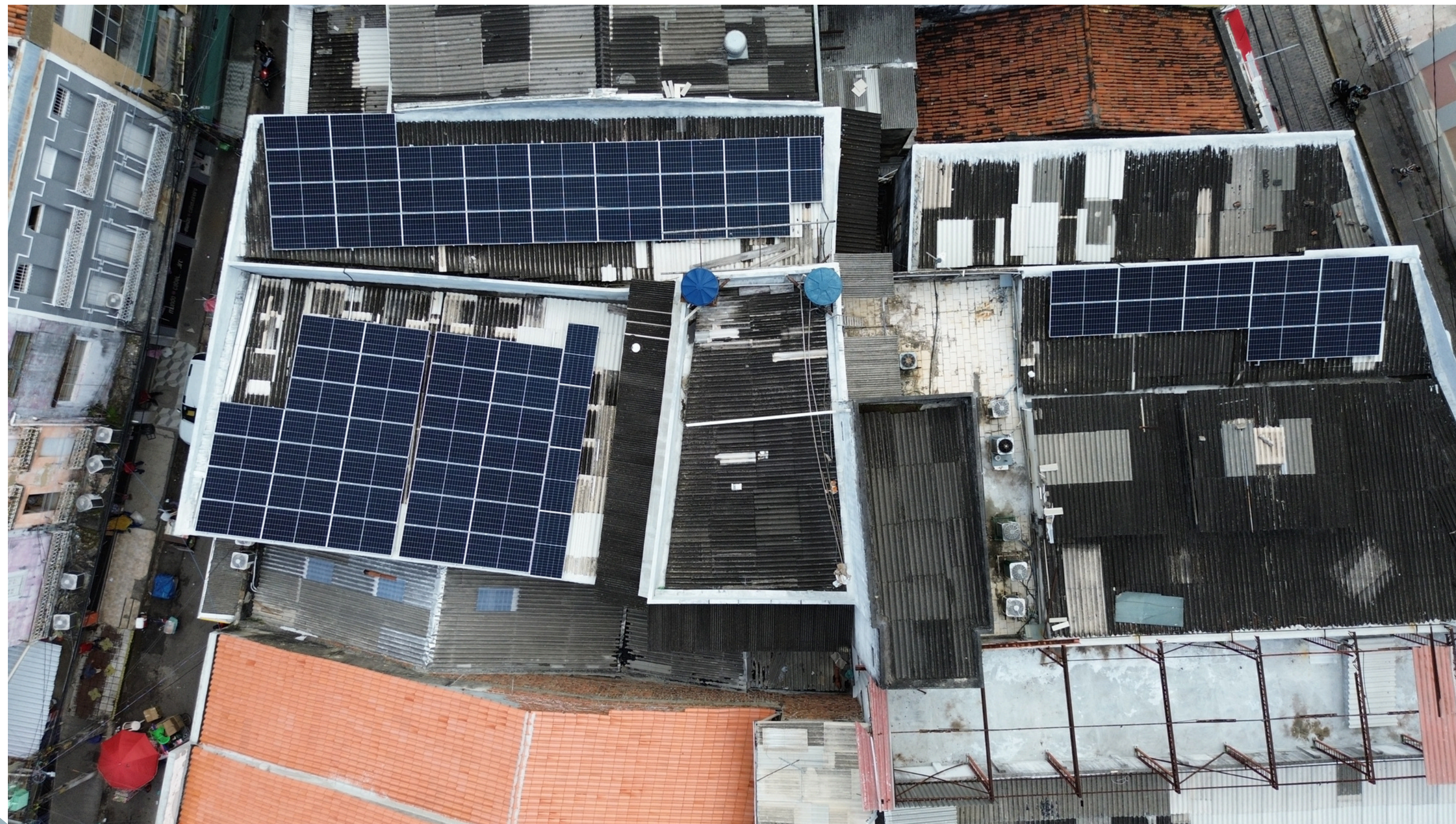
Galeria Casa Lapa 40,50 kWp - Recife/PE
