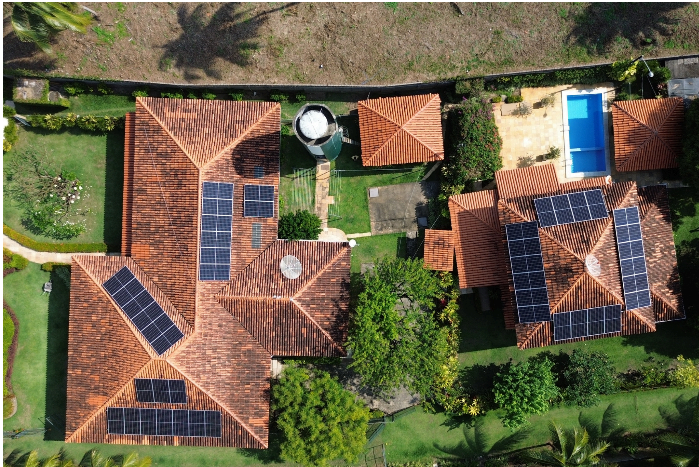
Sítio Maresia 29,48 kWp - Maragogi/AL
